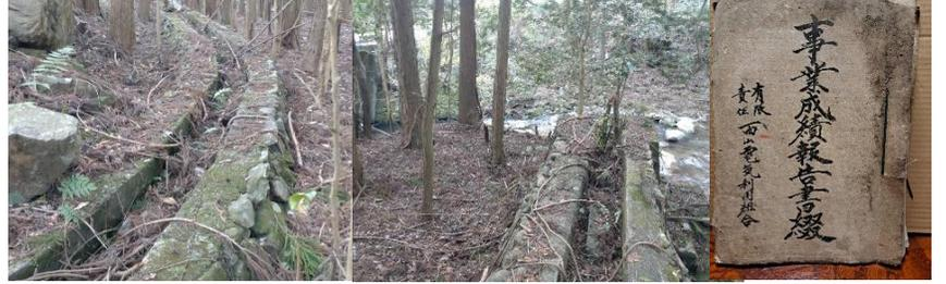
令和6年4月12日（金）水力発電の歴史を調べる為、「雨山電気利用組合」に関する現地調査を実施しました。雨山地内の道路の直ぐそばに、川を堰き止め水路を通した跡及び発電所があった場所を確認しました。同組合の資料も町内の個人宅から発見。昭和6年6月26日発電所水利使用の認可、同年12月3日工事着手届を名古屋逓信局長に提出、同月24日竣工して27日には使用開始届を提出しています。現在のように太陽光発電や原子力発電の無い時代に、当時の人が水力発電に賭けた思いを想像することが出来素晴らしいと思えました。今後は、自然エネルギーを活用して発電を思い描いています。
